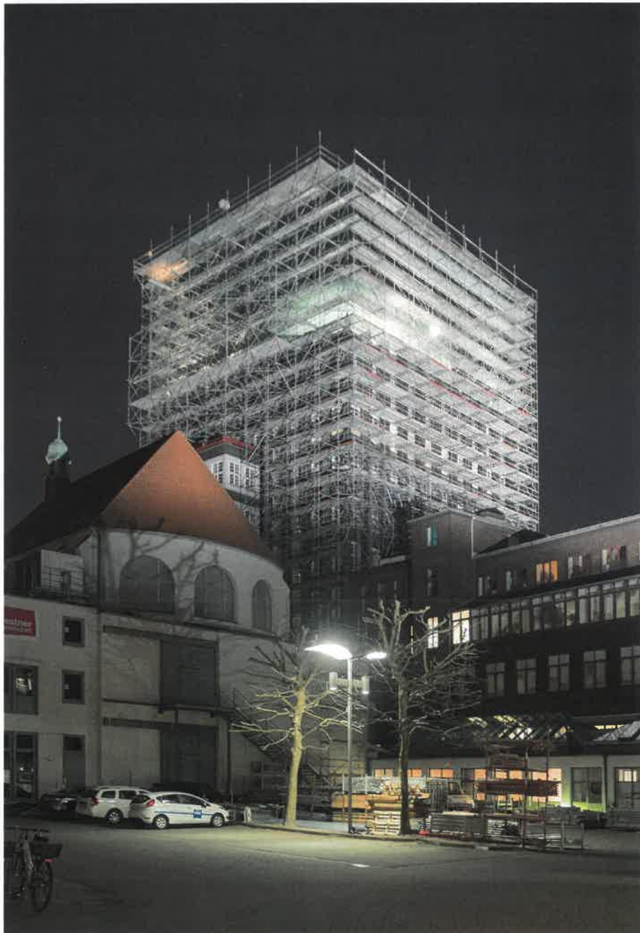
Im unteren Bereich musste das Anzeiger-Hochhaus von Schmiedt Gerüstbau in drei unabhängigen Segmenten mit Gerüst versehen werden, bevor oberhalb der nichttragenden Eckenbauten präzise der Ringschluss erfolgen konnte.
